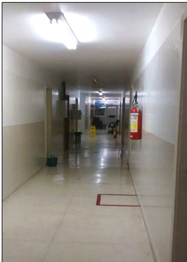
Corredor 2º andar
