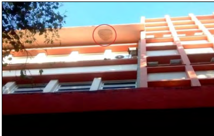
Desplacamento de reboco
