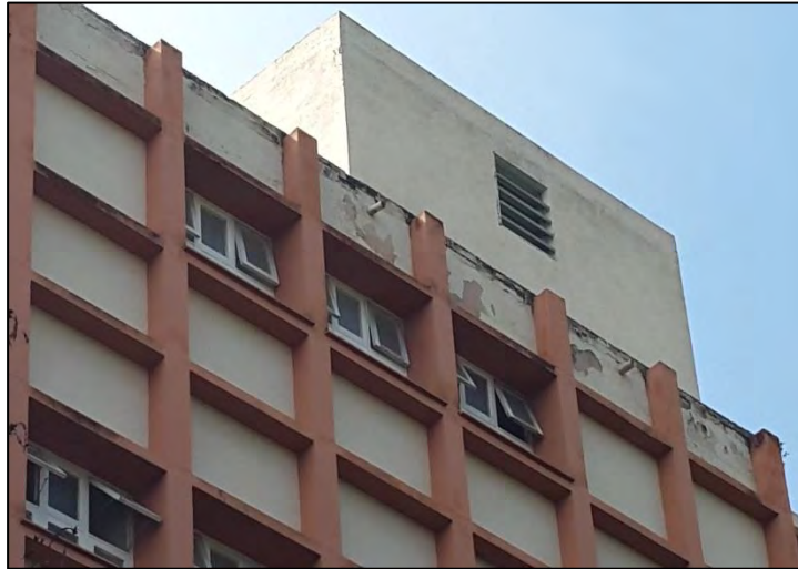
Desplacamento de reboco
