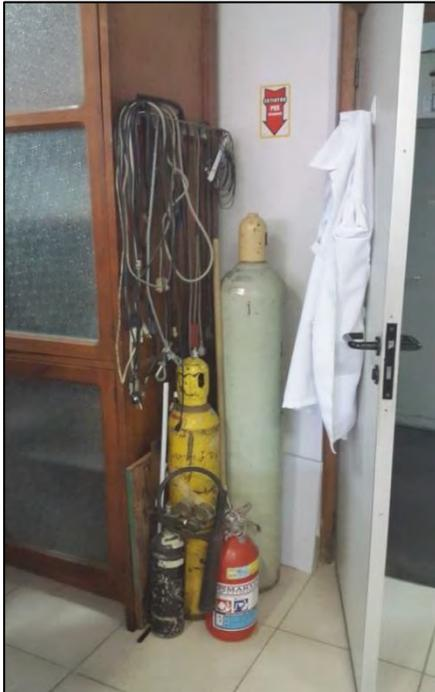
**Cilindros e extintores armazenados em local impróprio**
