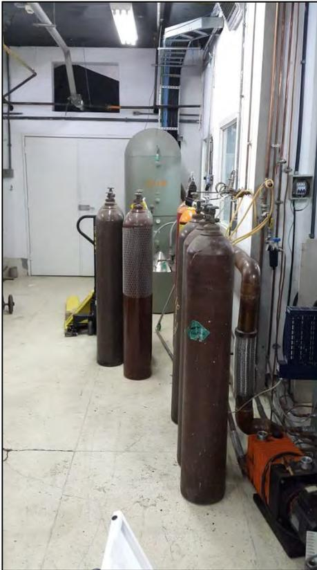
Diversos cilindros soltos e sem correntes de proteção
