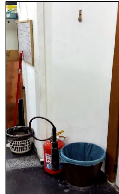
Extintor de incêndio sem a sinalização adequada e obstruído
