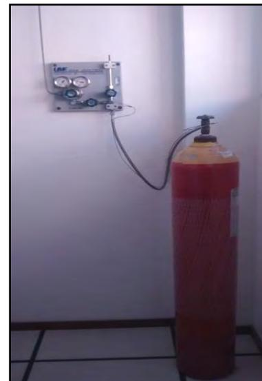
Cilindros sem sinalização, sem proteção e armazenados de forma incorreta.
