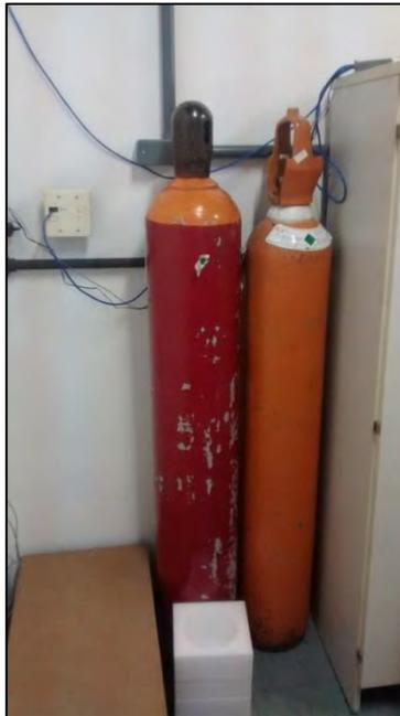
Cilindros em local inadequado
