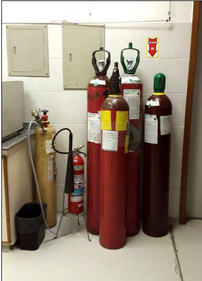
**Cilindros armazenados em local inadequado e obstruindo o extintor**
